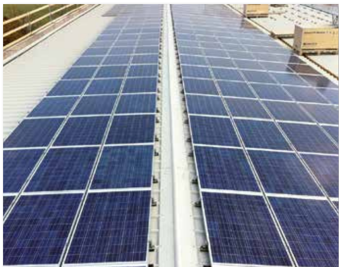
Techo de chapas acanaladas con FVT5000.
