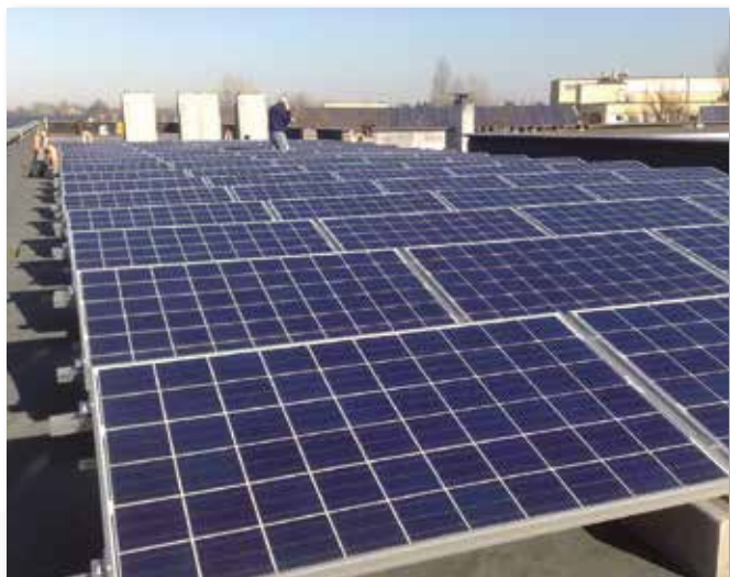
Techo con aplicación de lastre.
