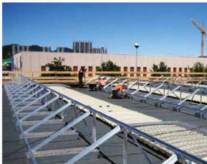
Techo vaina industrial plano Aplicación de tanques de lastre FVT1455 y triángulos de 30 ° FVT1511..
