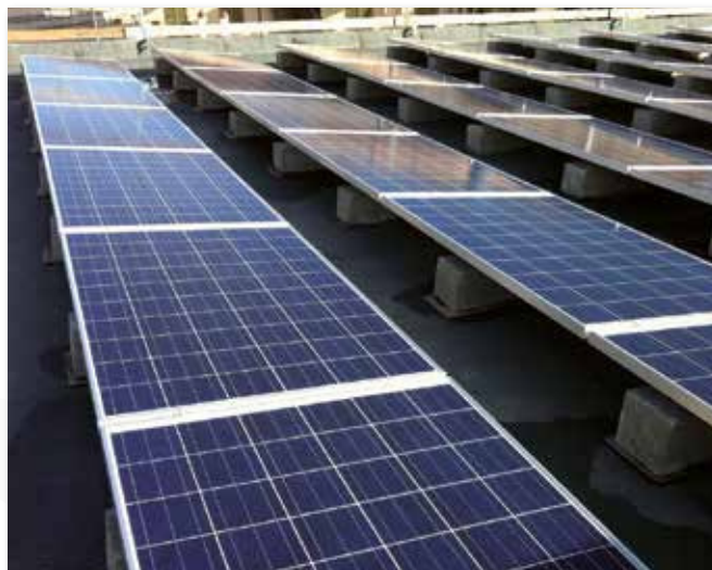
Panel horizontal con lastre "FLAT".
