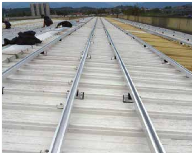
Techo con chapa acanalada. Montaje con soportes como por proyecto FVT95XX.
