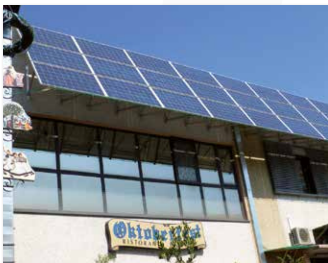
Estructura de techo inclinado.
