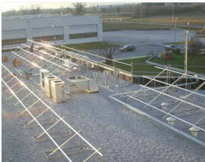
Techo industrial plano con grava. Aplicación con tanques de lastre FVT1455 y triángulos de 30 ° FVT1511.
