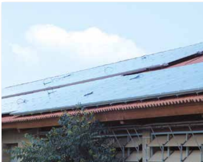
Techo inclinado – recuperación de amianto.
